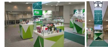
リニューアル工事一部 (ショールーム)
