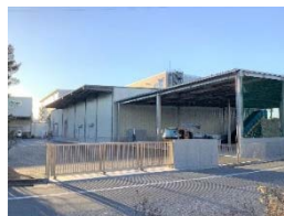
増設工場_外観
